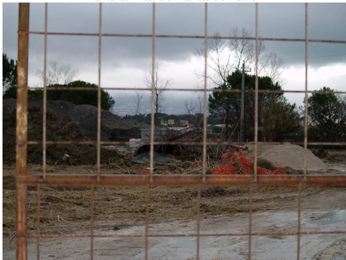
Foto 2 Panoramica dell'area dei lavori
