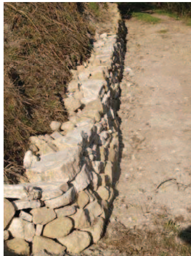
Foto 10 – Panoramica del muretto a secco
