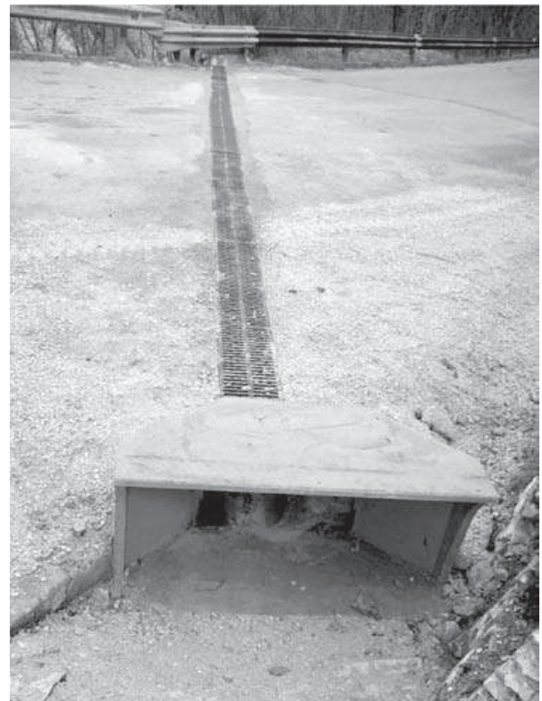
Fig. 2: il tunnel sottostradale realizzato per favorire l'attraversamento in sicurezza della carreggiata da parte degli esemplari di Salamandrina perspicillata in migrazione riproduttiva.
