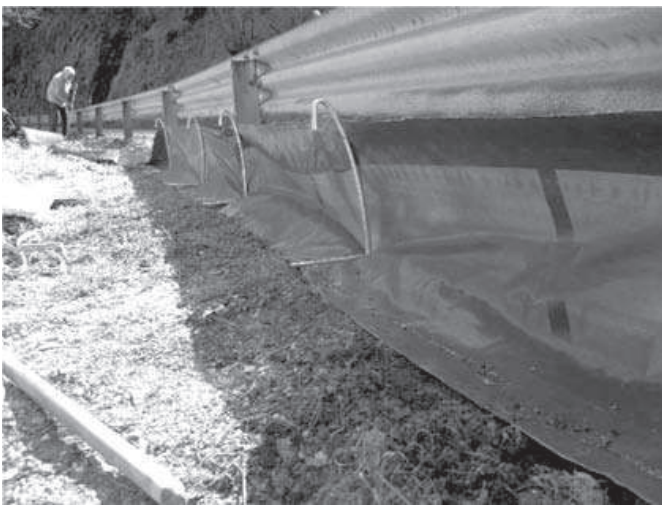
Fig. 1: la posa in opera della barriera antiattraversamento.
